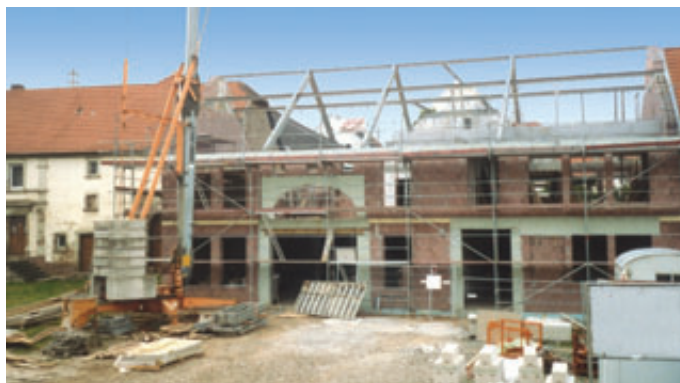
Schon nach kurzer Zeit lässt sich der Baufortschritt erkennen.
