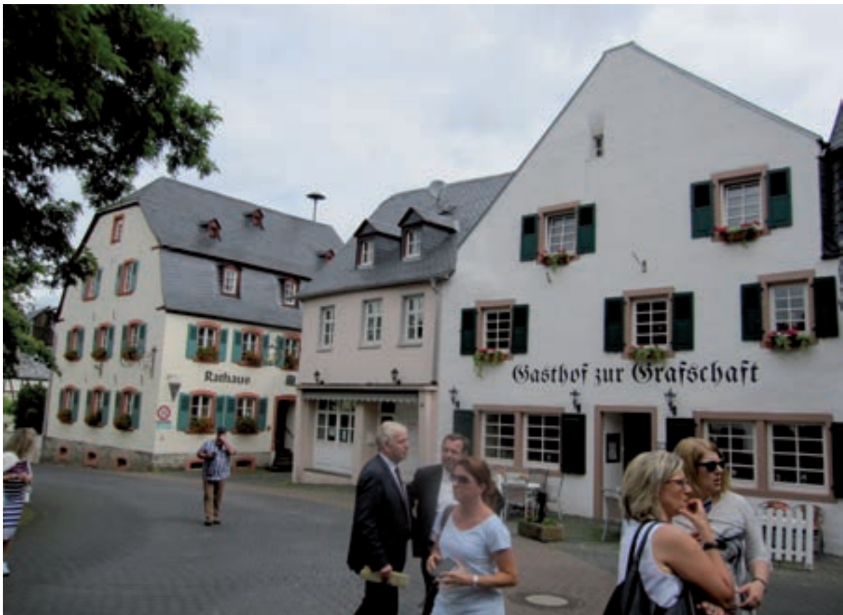
Die Sanierungsarbeiten an den Gebäuden wurden fachlich begleitet und im Sinne der Dorferneuerung ausgeführt.
