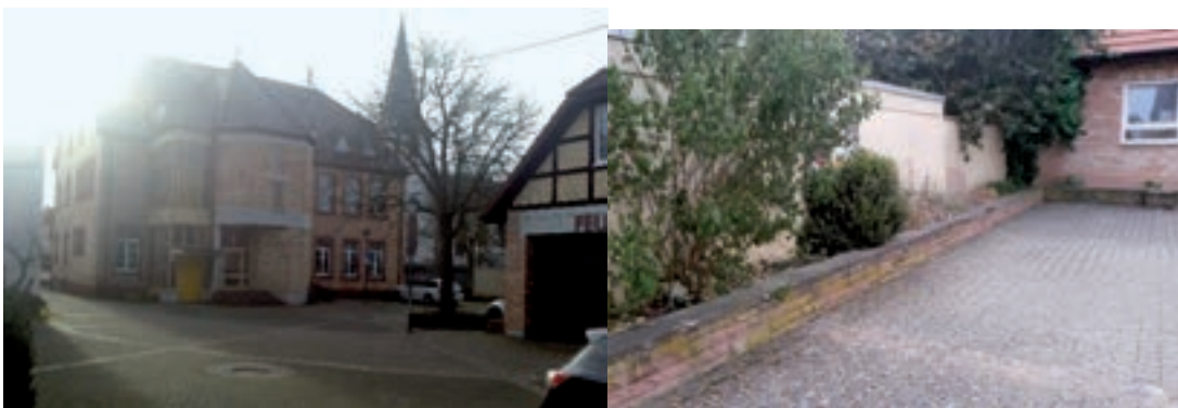
Bild 11 Bereich zwischen Feuerwehr und Bürgerhaus
